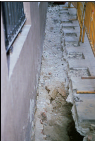
Foto 19. Foto de l'obertura del tram 2 de la Rasa 2 (030/03-39)
