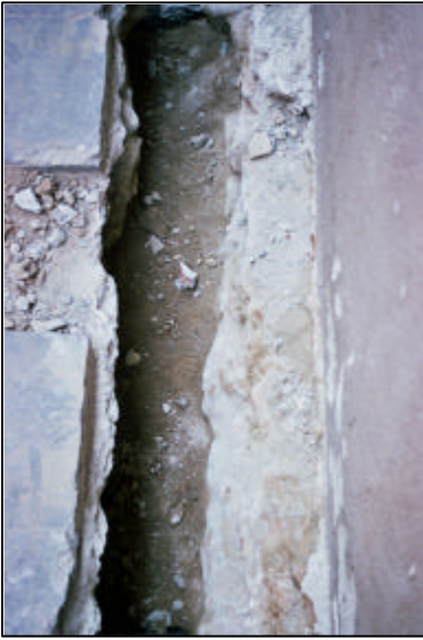
Foto 20. Foto detall d'una secció del tram 2 de la Rasa 2. Perfil de la secció H-H', amb vista de la fonamentació (u.e. 312) de l'edifici d'Elisabets 19 (030/03-40).
