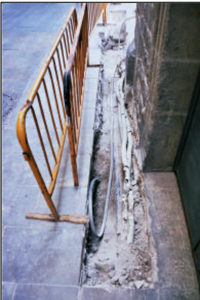
Foto 18. Detall obertura tram 1 de la Rasa 2, vist des de l'oest (030/03-38)
