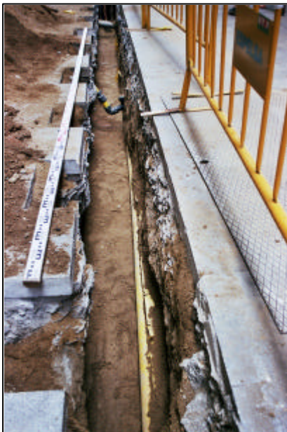
Foto 15. Foto general tram 3 de la Rasa 1, vist des de l'oest. (030/03-28)
