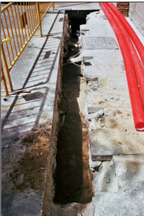
Foto 13. Foto final tram 2 de la Rasa 1. Detall dels nombrosos cables de serveis, i el farciment de la pròpia rasa. (030/03-24)
